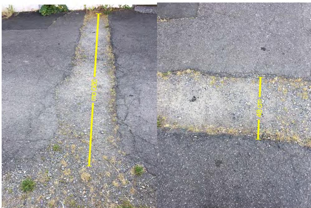
1. Comblé la saignée avec de l'enrobée à froid afin de permettre le passage d'un fauteuil roulant et éviter tous risques de chutes.
